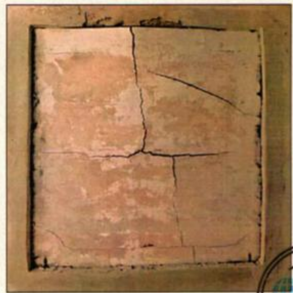
KONDISI PERMUKAAN DEPAN BENDA UJI (EXPOSED SURFACE) SETELAH UJI
