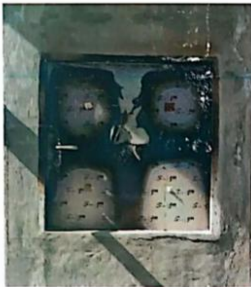
KONDISI PERMUKAAN BELAKANG BENDA UJI (UNEXPOSED SURFACE) SETELAH UJI
